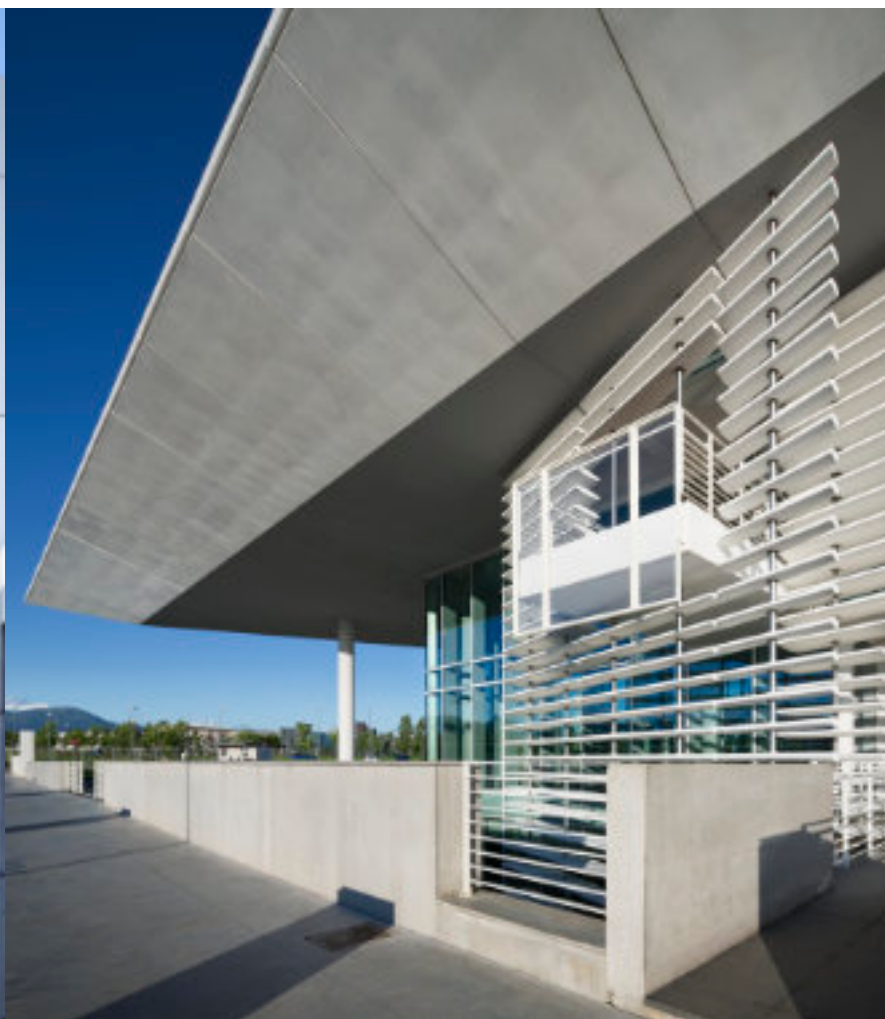
Pannelli prefabbricati I.Lab,Bergamo
