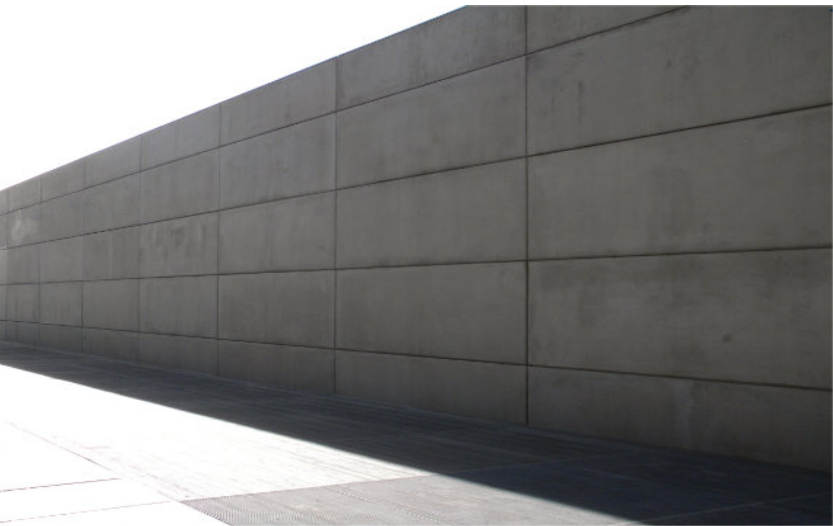
Pannelli prefabbricati I.Lab,Bergamo
