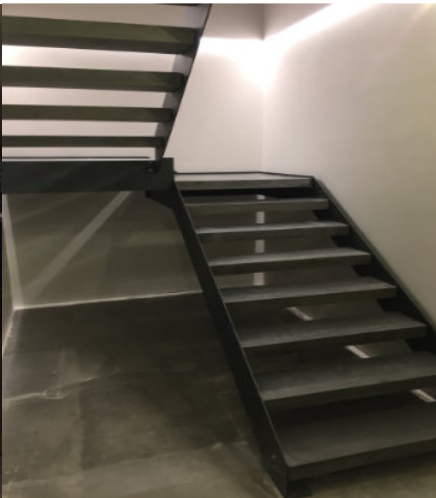
Scala metallica rivestita con elementi sezione L
