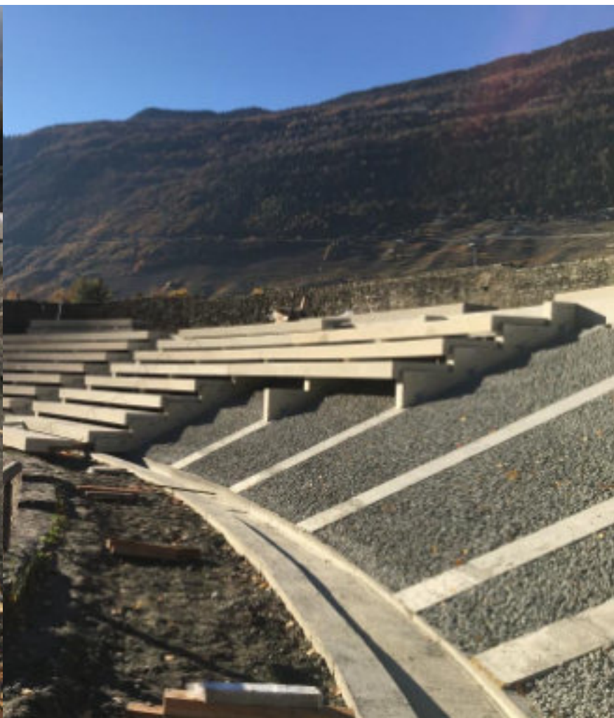
Sistema di posa a secco progettato ad hoc
