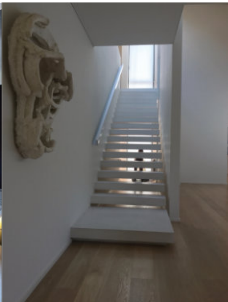
Scale a sbalzo, prefabbricate su misura
