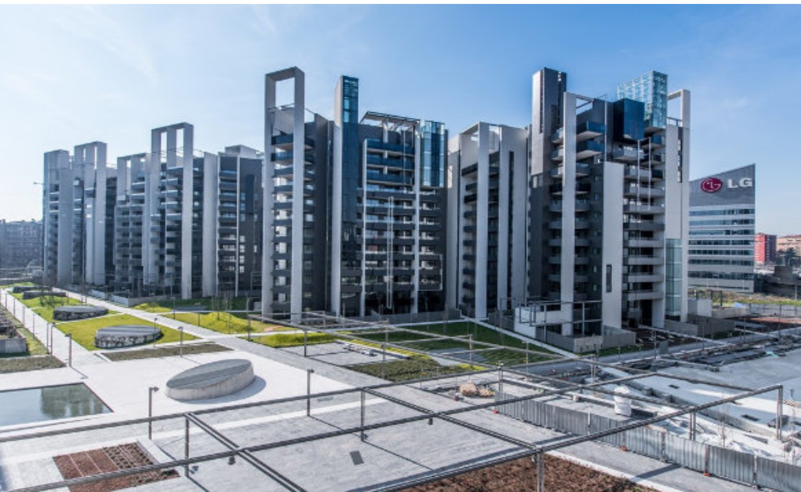
Parapetti ed elementi di facciata palazzi di Porta Vittoria, Milano
