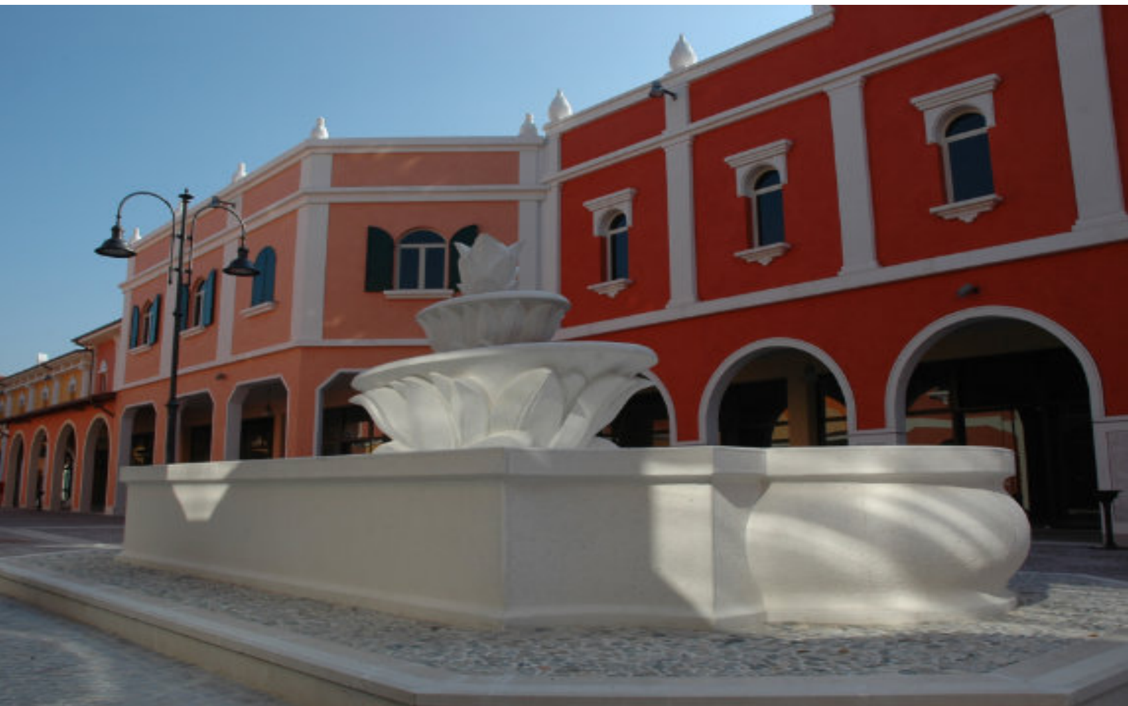
Fontana decorativa ed elementi decorativi di facciata
